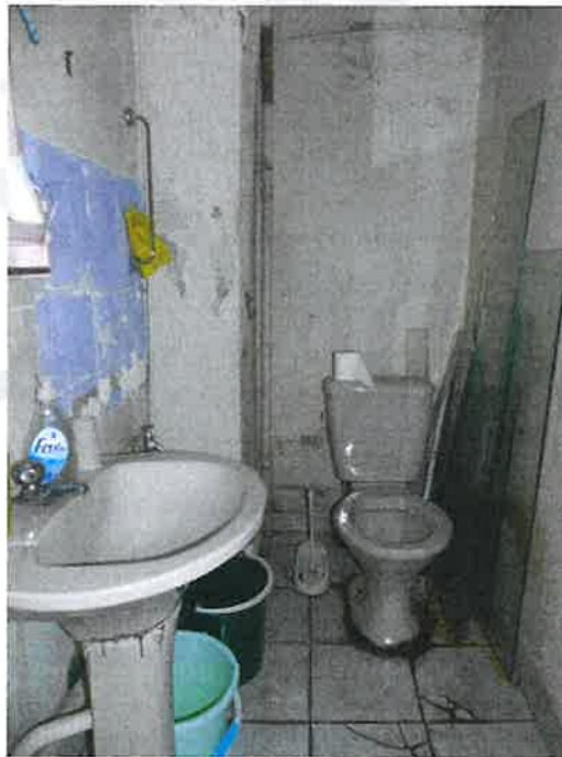
Foto 9 Toilet – Breedestraat 117A
