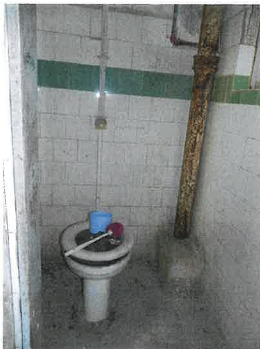
Foto 5 Toilet begane grond
