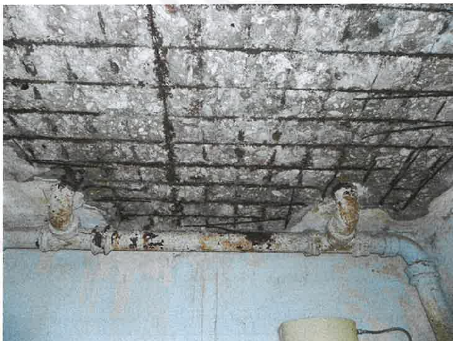
Foto 4 Plafonddetail begane grond
