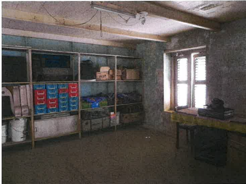
Foto 7 Slaapkamer verdieping (Breedestraat 113)
