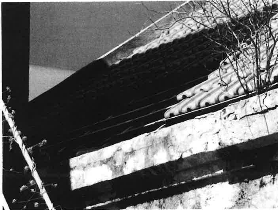
Foto 9 Dak detail – Brionweg 8
