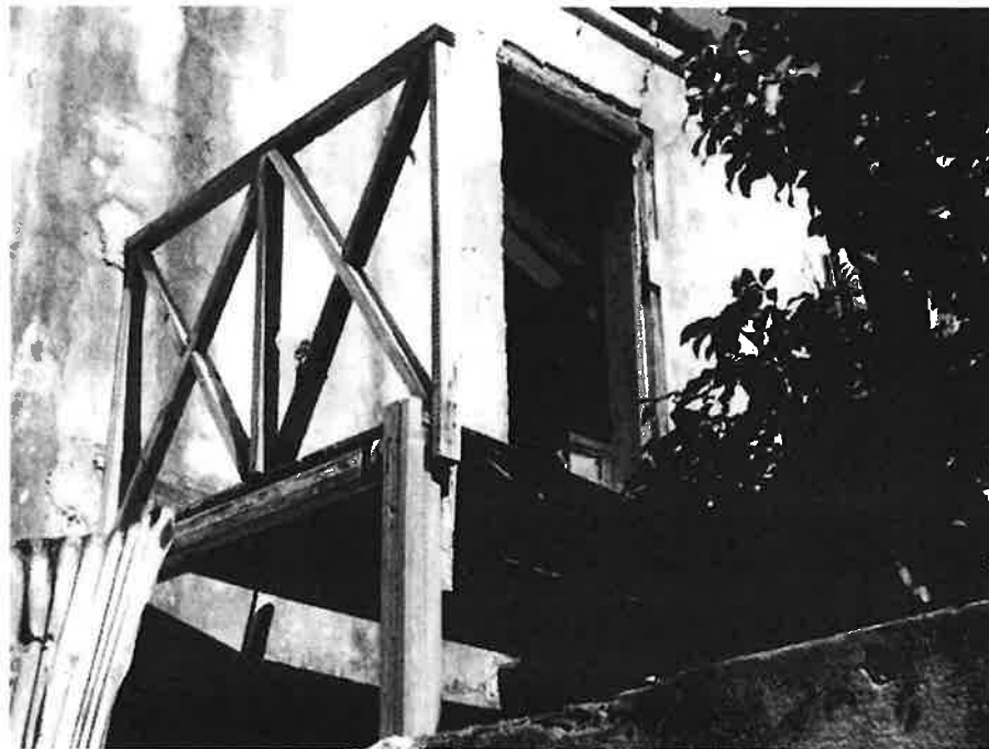
Foto 20 Vloer- en muurdetail – Pieterszsteeg 25-27
